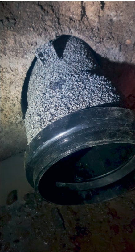
Das Anschlussstück wird sauber eingebaut und befestigt.
