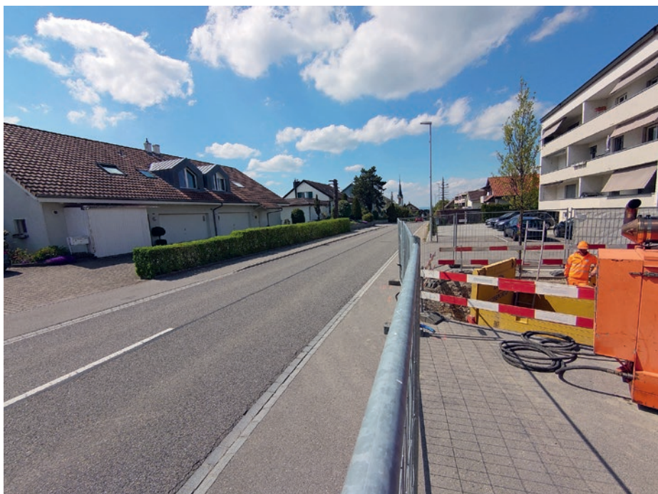
Ausgangslage: Die Leitung wird rechts von der Maschinengrube, unter der Fahrbahn hindurch, mittels Pressbohrung auf die andere Seite verlegt.
